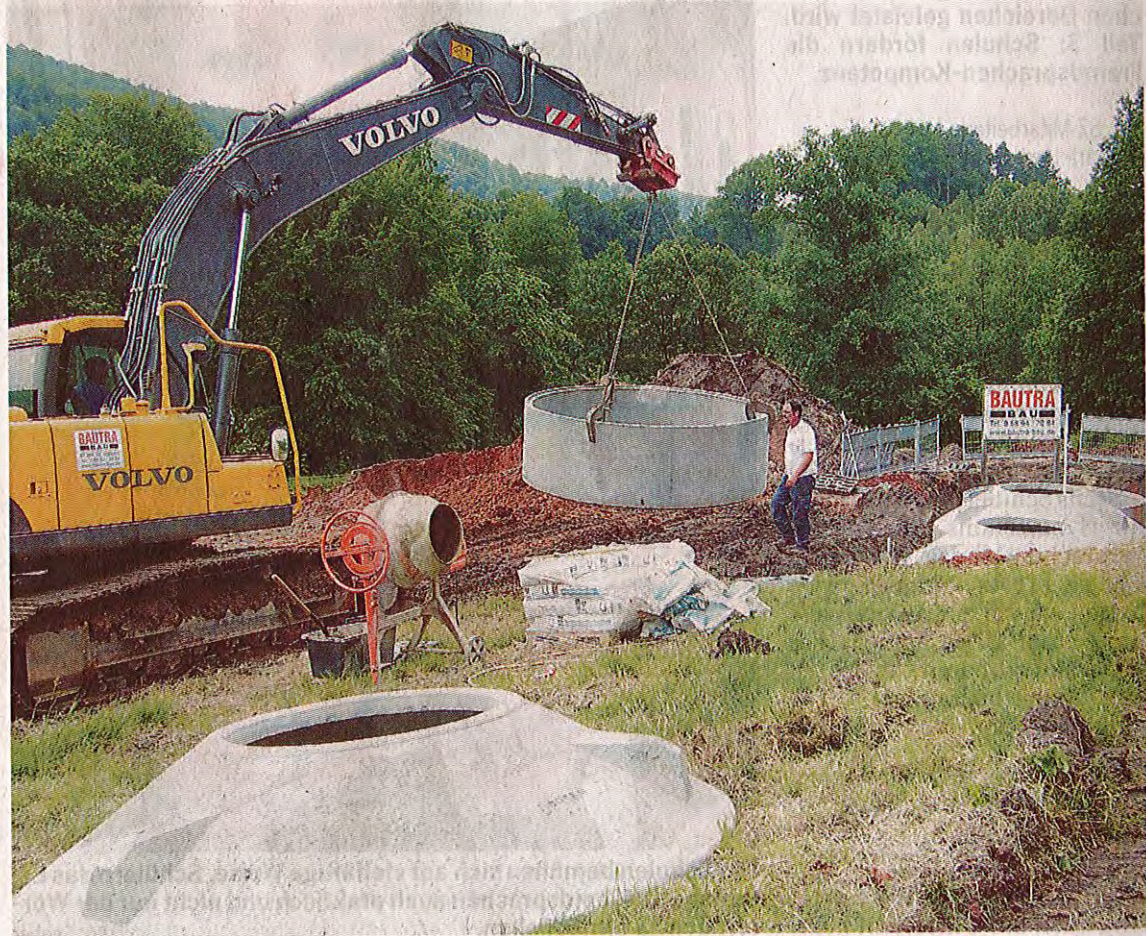
Eine neue Kläranlage wird auf dem Gelände des Tribscheider Hofes bei Hassel gebaut. Foto: Malter
